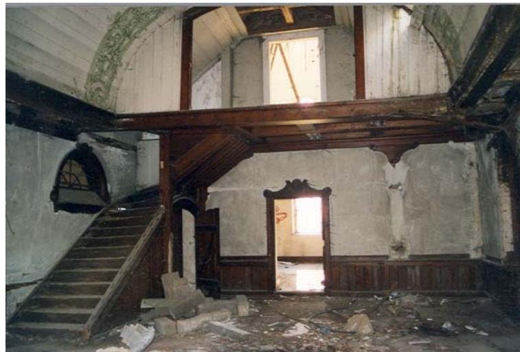
Jagdsaal mit Zugang Turmbau, Empore und bretterverkleideten, bemalten Tonnengewölbe – Zustand 2001 (Quelle: Amt für Kultur und Denkmalschutz)
